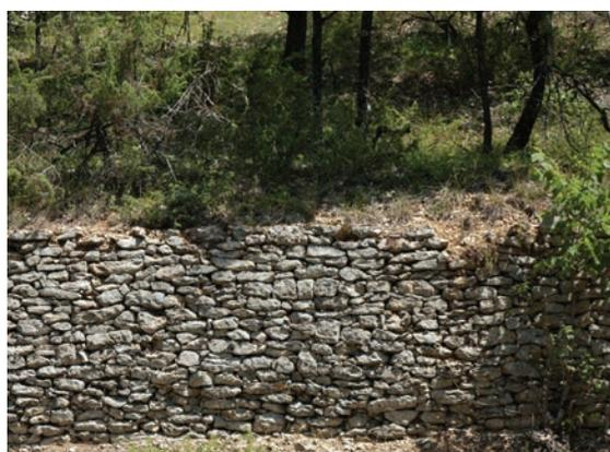
► Soutènement en petits moellons assisés au Montat (46)
